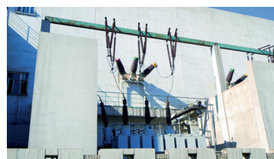
Fixação de estruturas de suporte.
