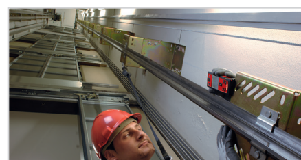
Desenhado e aprovado para cargas dinâmicas, por exemplo para instalação de elevadores.
