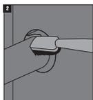
**Limpeza do tubo plástico:** retirar todos os vestígios de argamassa ou pó do tubo na área onde a Abraçadeira Intumescente será instalada.
